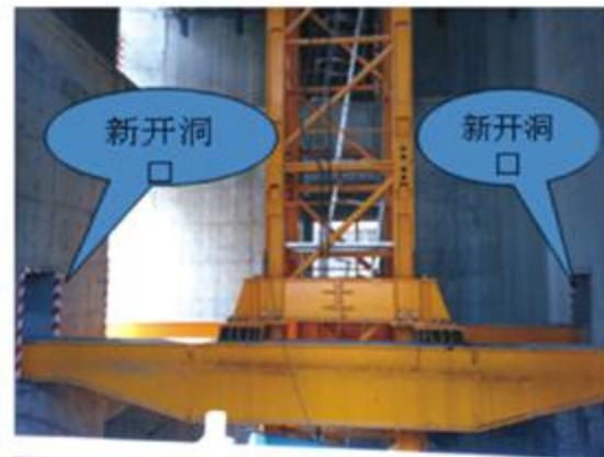
图4 塔吊钢梁安装效果图
