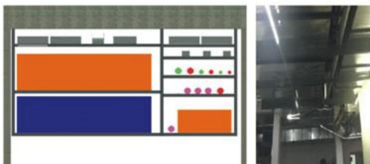
所示的是地下一层31号支架, 包含了电缆桥架、母线、热力管道、消防管道、排烟风管。
