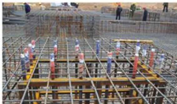
图7 锚栓固定架固定图
