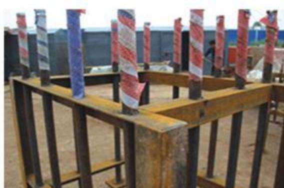
图5 锚栓固定架
