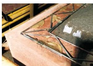
图3-3 不锈钢拉结网安装
