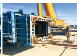
图8 钢筋笼与模板整体连接
