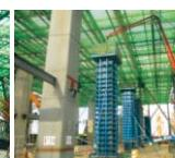
图12 柱混凝土浇筑
