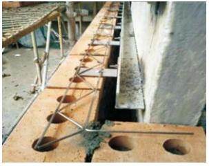
图3-9 Z型不锈钢网片安装
