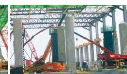
图13 柱混凝土养护
