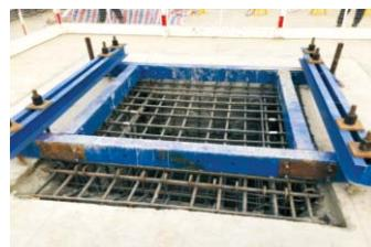
图9 柱模板定位底座
