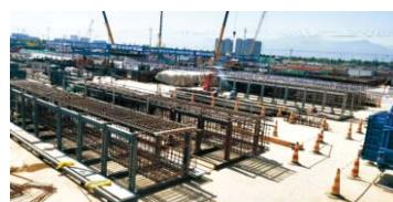
图7 柱钢筋笼场外集中加工制作
