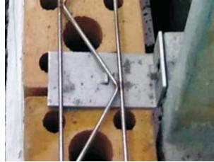
图3-10 不锈钢水平拉结件安装
