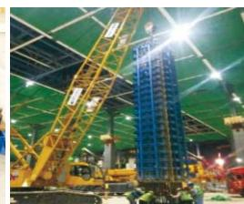
图10 现浇混凝土柱模板钢筋整体吊装
