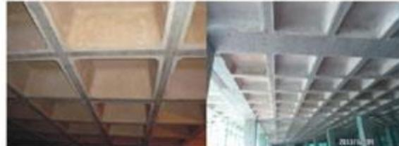
图11 施工拆模后效果图
