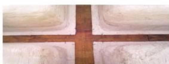
图5 用铁钉固定模壳
