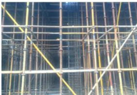
图1 承插型盘扣式脚手架
