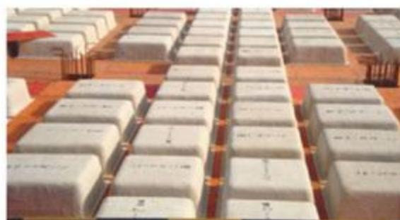
图6 Pk免拆模壳安装效果
