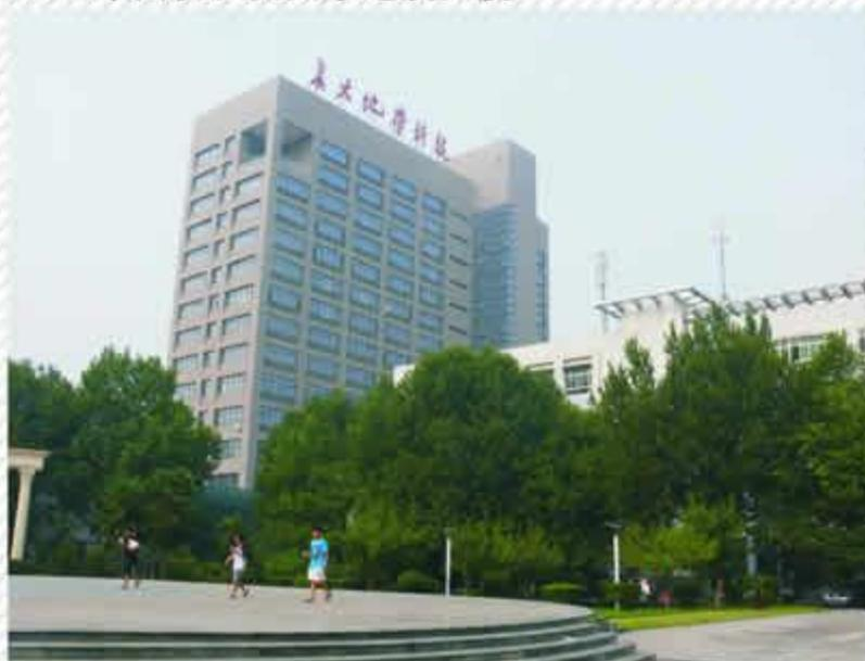
地质大厦工程，位于西安市雁塔区雁塔路长安大学南校区内，建筑面积23716m<sup>2</sup>，钢筋混凝土框架结构，地下1层，地上15层，地下室为设备机房、库房；地上1~15层为教学研究的办公用房，底层设有恐龙展馆。设有给排水、通风、采暖，消火栓、自动喷淋、气体保护、防火卷帘、防排烟消防、动力、照明、防雷、通讯、安监、自动化办公等系统，4部电梯，1部兼作消防。是一座集学术会议、展览、实验室、研究室、办公用房、地质博物馆和恐龙化石馆等为一体的综合性大厦。
