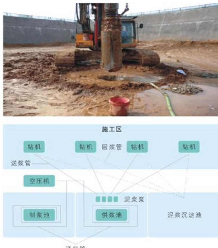
图3 聚合物泥浆循环系统的配置
