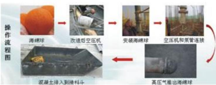
空压机海绵球替代水洗泵管操作示意图
