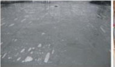
结构板面塑料薄膜覆盖养护
