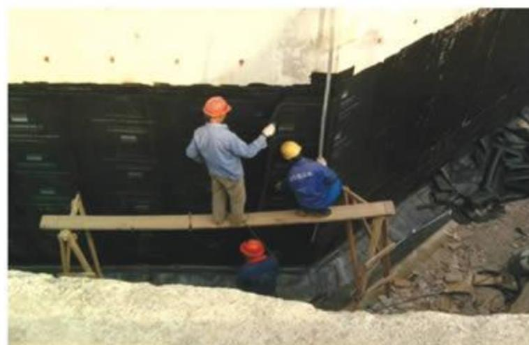
图4地下室外墙壁的接头处理办法
