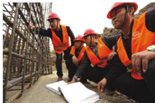
3月23日，项目复工后的第9天。项目领导郝小堂、杨国栋、冯靖、张洪，检查桥梁钢筋绑扎质量，合格后即将进入下一道工序
