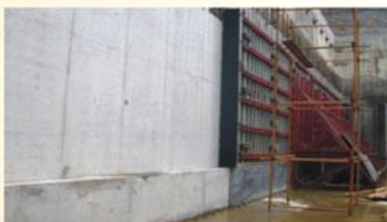
图5.2.2三角桁架钢模体系加固施工效果
