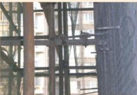
图五 设置在剪力墙上
