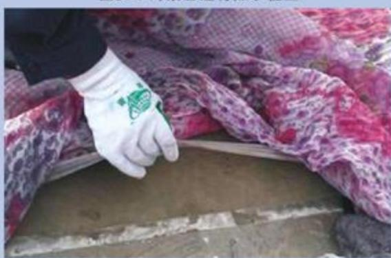
图3-2 现浇板混凝土双层覆盖养护
