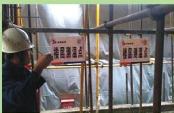
图3-10 预埋测温探头及楼层测温点效果
