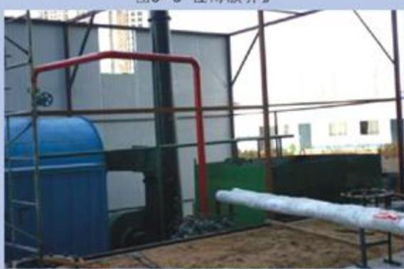
图3-4 从锅炉房分汽缸引出两趟蒸汽管道并进行保温
