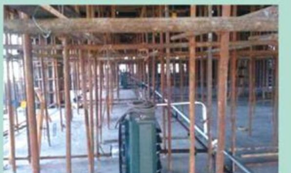
图3-7 楼层安装暖风机效果
