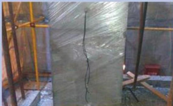
图3-3 柱薄膜养护
