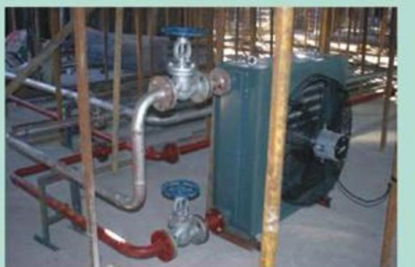
图3-7 楼层安装暖风机效果
