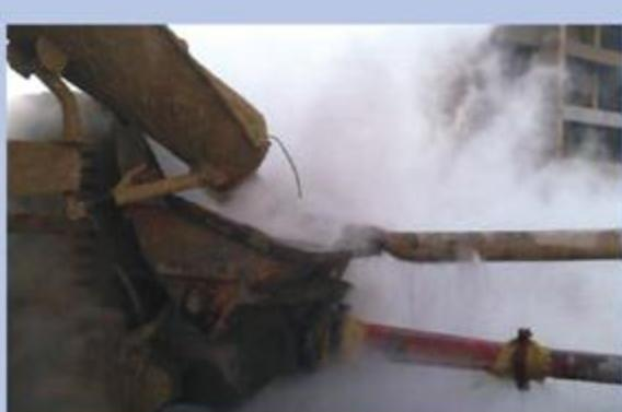
图3-1 对泵管进行热水检查
