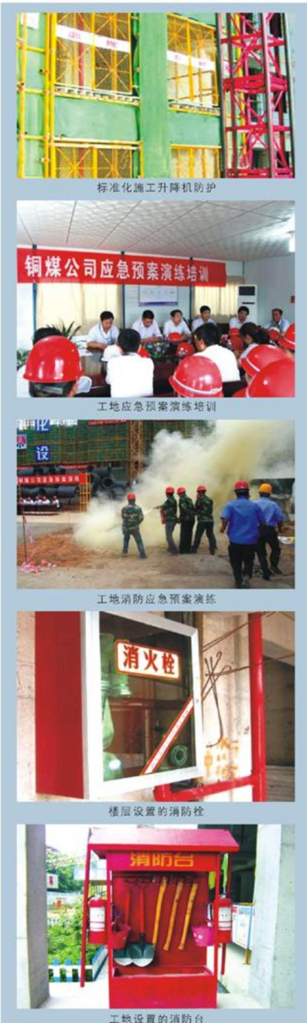
岗。严格执行三限位、两保险、十不吊规定。施工升降机四面用安全网防护，进出口设置防护门及防护棚，专职司机进行操作，确保施工机械使用安全。
