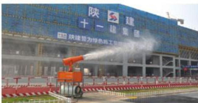
西安理工大学图书馆工程移动式喷雾降尘设备
