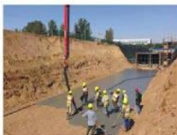
图4 垫层浇筑
