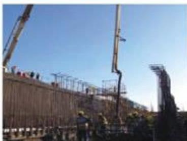
图10 底板混凝土浇筑
