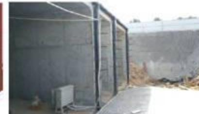
图7 变形缝处实景图
