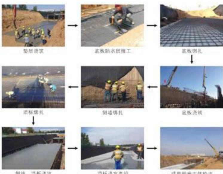
图1 管廊仓体施工工艺流程
