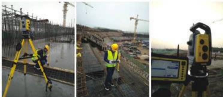
图25 测量机器人放线定位
