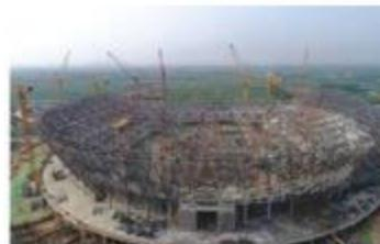
图3 罩棚钢结构
