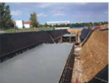
图11 顶板及侧墙混凝土浇筑
