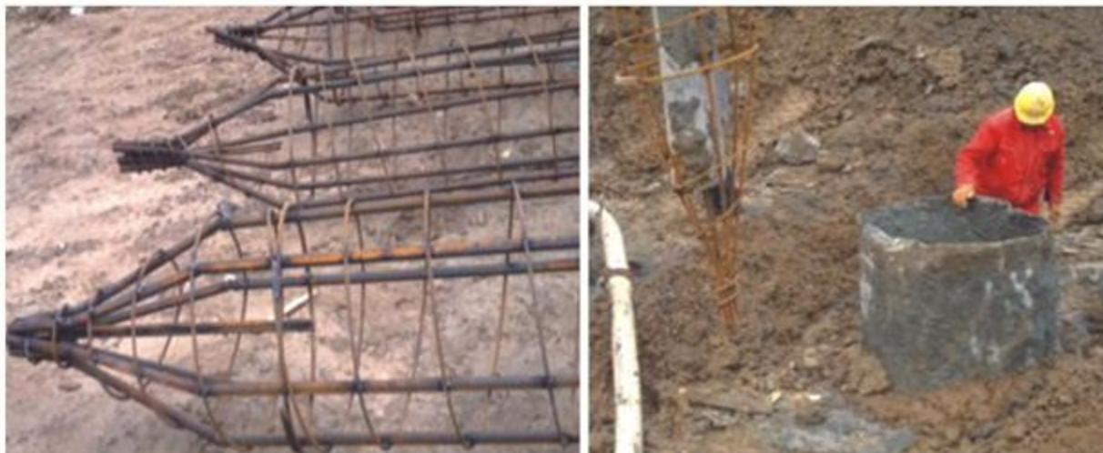
28米长笼在地面水平起吊穿入送笼器有困难，需在场地钢筋加工场附近先成孔 $\Phi 600\text{mm}$ 深度12米的空孔，用来接钢筋笼子。
