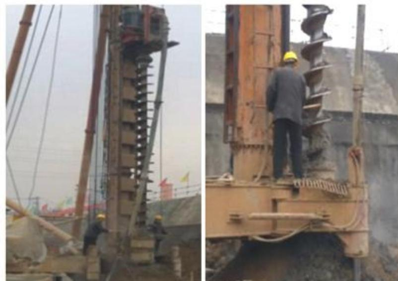
3、压灌混凝土完毕后，移机露出孔位，利用铲车和人工清除孔口渣土，再在孔口处安放一个盛计算好下钢筋笼上翻的混凝土套筒，同步利用调车将加工好的钢筋笼穿入送笼器，钢筋笼加工为便于下笼，需将主筋在端部均弯向中心形成一个尖锥型，在距尖头 $100\text{mm}$ 位置用 $\Phi 8$ 的钢筋转四圈焊接箍紧，在尖内放入 $2$ 个 $\Phi 16$ 的钢筋做成U型并交叉固定好，以保证钢筋笼在震动中能完好的下到桩底，钢筋笼主筋间距误差控制在 $\pm 10\text{mm}$ 以内，箍筋间距误差控制在 $\pm 20\text{mm}$ 以内，笼径误差小于 $\pm 20\text{mm}$ ，笼长误差小于 $\pm 100\text{mm}$ 。因
