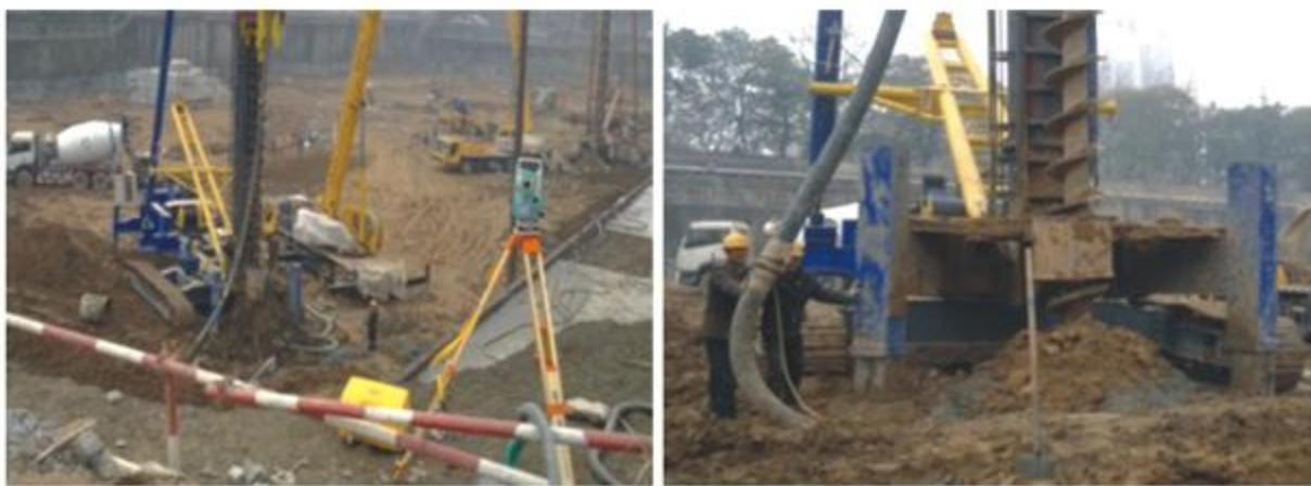
无误后填写桩位测放报审表，请监理单位检查验收。合格后移动桩机到位，调整支撑杆件，使机身保持水平。使桩管垂直对准桩位点，垂直度最大误差应控制在 $\leq 1\%$ 以内，高程点误差控制在 $\pm 2\text{mm}$ 以内，工程桩位误差控制在 $\pm 20\text{mm}$ 以内。
