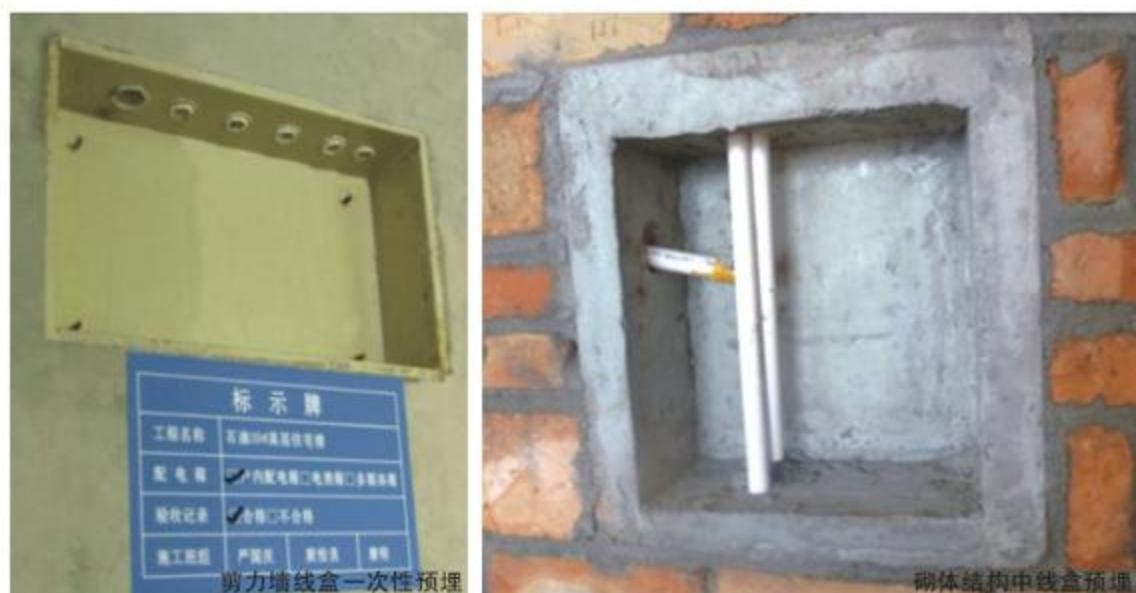
安装线管等。因此，主体施工过程中，我们在剪力墙结构内，提前安装好所有的线管及线盒，并做好线盒安装部位的钢筋补强工作，混凝土浇筑完成后，所有的线管及线盒一次成型。在室内填充墙砌体施工过程中，我们随着砌体施工进度将线管、线盒等直接埋设于砌体结构内。后期管线安装时，只需要在预埋线管内穿线，不需要进行二次槽，有效的避免了因管线安装而引起的墙面损坏。
