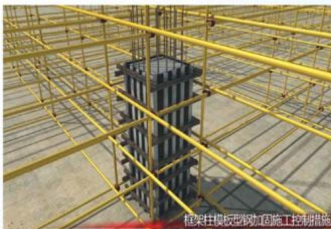
图八 框架柱模板加固施工控制措施
