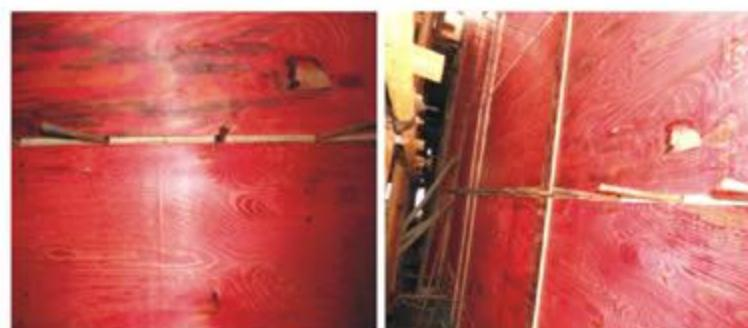
图五：模板拼装螺杆放置
