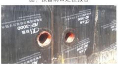
图：给水管穿过混凝土外墙，现场预留洞口
