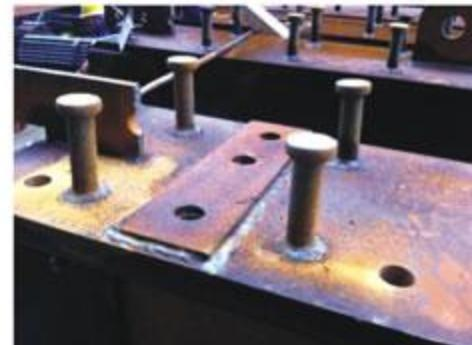
图8 梁翼缘板处插筋开孔加强焊板
