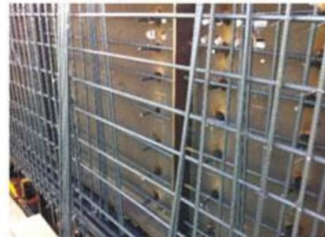
图7 挂设拉筋的构造纵筋
