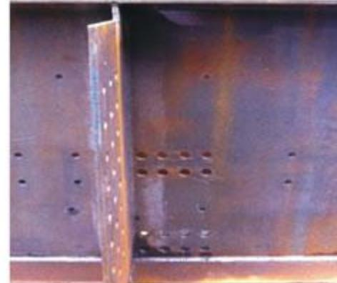
图6 次梁钢筋、板筋、螺杆孔位
