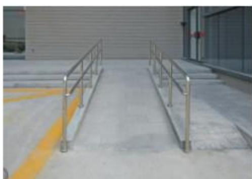
**亮点22** 水泥散水，面砖镶边、油膏嵌缝，
