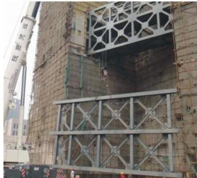
构件GL1、GZ1、XG1在地面拼接拼装成整体单元，长约16.5m、宽0.4m、高8.0m，单片重量约15T，在单元重心设置二个吊点，采用吊车整体吊装。
