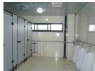
**亮点16** 60间厕所、盥洗间4面墙砖，全部做到墙地对缝、墙顶对缝。
