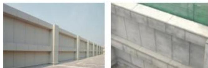
大面积女儿墙面水泥砂浆粉刷无空鼓裂缝
