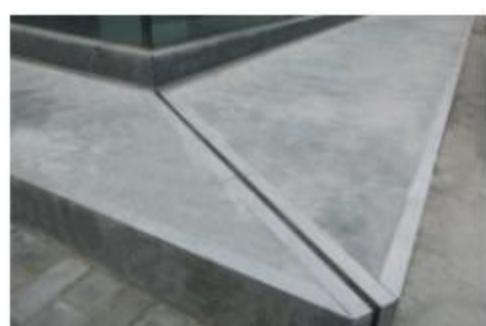
**亮点23** 地下室大面积混凝土地坪颜色一致、无空鼓裂缝和跑砂。
