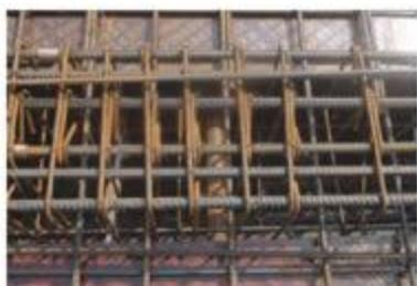
图4-3-5套管实际预埋图
