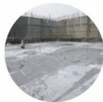
混凝土采取薄膜覆盖养护措施，杜绝无措施浇水养护
