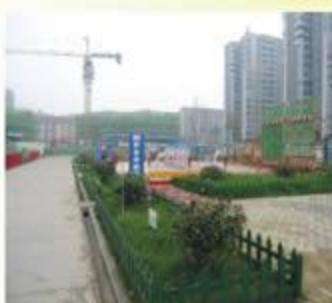
地面采用混凝土硬化、铺透水砖及绿化相结合
