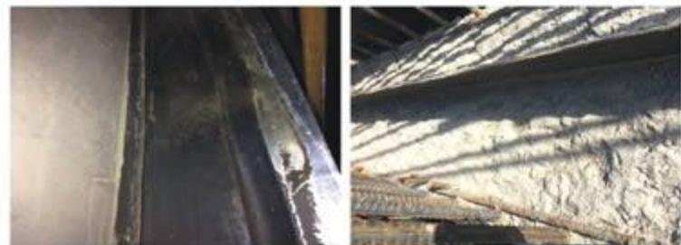
图26 钢边橡胶止水带成型效果
