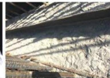
图27 伸缩缝处混凝土凿毛处理
