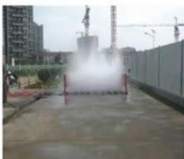
大门口设冲洗设备，同时设三级沉淀池，冲洗用水循环使用
