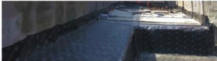
图23 出线节点防水卷材施工
