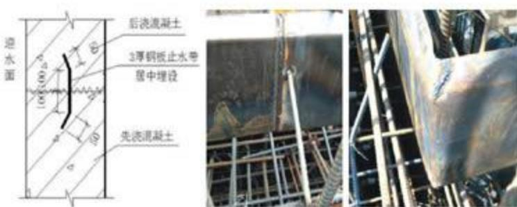
图24 昆明路地下综合管廊项目止水钢板定位焊接
