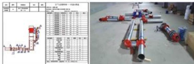
图3-2-7 (b) 机房预制加工表
