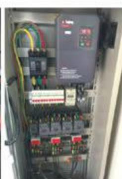
单独安装电表，分批计量。水泵控制器采用微电脑时控开关，降低人为浪费
