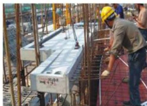
图 3.4.2-8 预制阳台板吊装示意图
