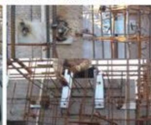
图 3.4.2-5 相邻PC板连接方式
