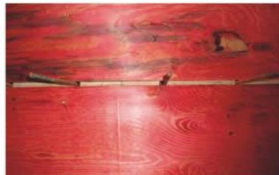
图二 模板拼装螺杆放置
