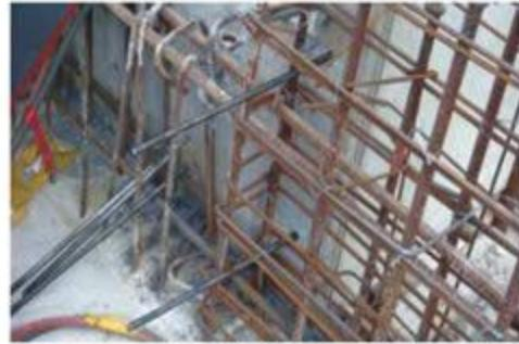
图 3.4.2-11 在PCF板上安装对拉螺杆示意图
