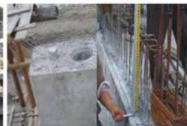
图 3.4.2-1 PC板水平度和标高调整方法
