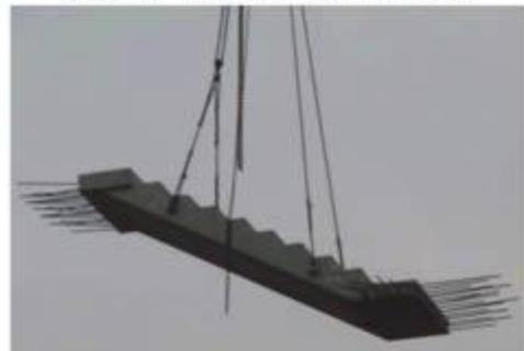
图 3.4.2-9 预制楼梯吊装示意图
