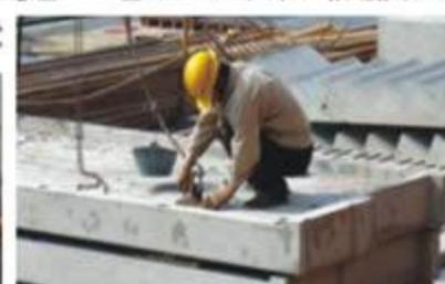
图 3.4.2-7 预制阳台板安装吊耳图
