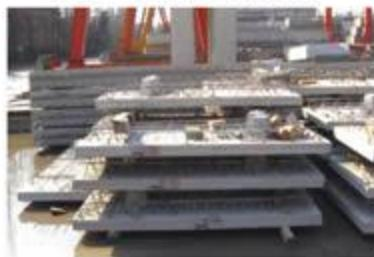
图 3.3-7 水平预制构件堆放方式
