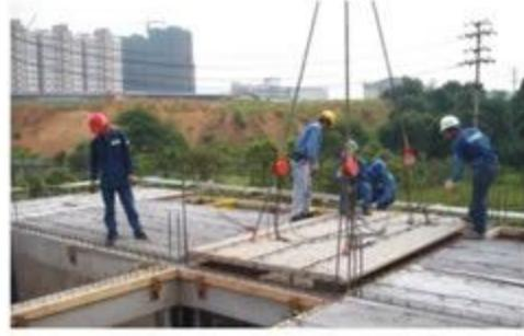
图 3.4.2-13 预制楼板模板的安装效果图
