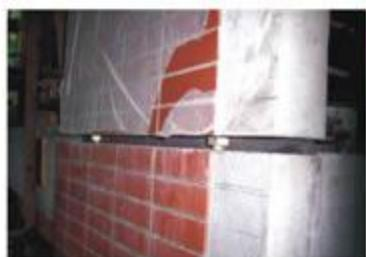
图 3.4.2-2 上下两块PC板之间的缝隙
