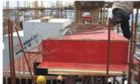
图 3.4.2-10 预制楼梯安装示意图
