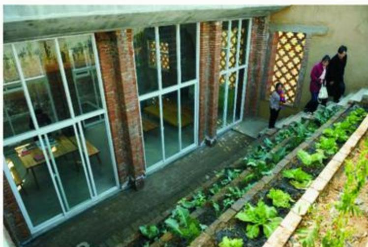
生态农宅设计为一家三代合住，内有土炕两座，一座与厨房连接，做饭所产生的热量，可直接进入火炕。住宅北部为卫生间、储藏室和猪圈。住宅中央有类似于传统四合院的天井，只不过天井被一个水泥围成的“池子”代替，该池子的用途主要为洗菜洗衣。水泥池往北有一客厅，里面置放着原始、简单的木质家具。住宅最北面为台阶式结构，台阶上种植着朝天椒、白菜等蔬菜。传统房屋屋顶均为平顶结构，而该农宅的屋顶是台阶式结构，且面积较大，可用于种植农作物或者收集雨水等。
