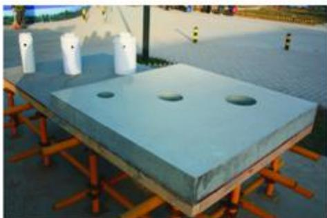
1、结构板预留洞样板：结构板预留管洞工法，在结构板上预留管道孔，方法简便，效果好。
