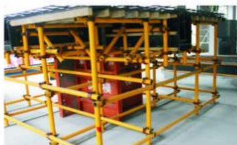
7、顶板模板水平支撑采用定尺钢管，既保证了模板支撑体系的强度、刚度，保证安全，又可以对顶板标高进行有效的控制
