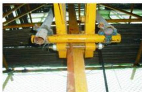
8、爬架使用HS2010-2型新型爬架，防坠吊齐全有效，架板采用定型化钢制脚手板。
