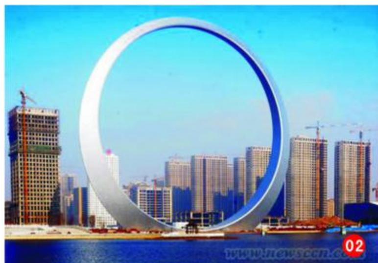
◆ 02 “生命之环”坐落于辽宁抚顺市沈抚新城，外径170米，内径150米，结构顶标高153.98米，钢结构总重3500吨。投资金额总计1.12亿，11月12日，微博传“生命之环”将完工，但多个娱乐功能被取消，仅供观赏。
