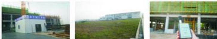
2、配置分贝仪，对施工现场的噪声时刻监控，对噪声较大的固定操作机械设置隔音棚（如封闭式木工加工车间），降低噪声传播的功率；对挖机等施工机械安排合理作业时间，减少对外界的影响。
