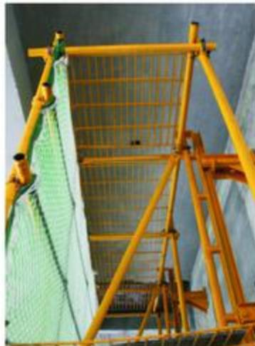
6、使用6kg钢筋网片脚手板，替代了传统式的竹架板，可利用现场的废旧钢筋自行制作。本架板适用于各种钢管脚手架使用，利用率极高，重量轻，可周转，安装方便，成本低，安装成型后美观坚固，符合安全防护的要求。
