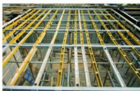
9、数字化龙骨的引入和运用，有效的避免了以往施工过程中因裁切随意导致的浪费，在一定程度上增加了方木的周转次数，降低工程成本使用数字化支撑降低方木投入250m<sup>3</sup>。
