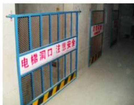
11、所有防护体系均实现定型化、工具化。临边防护栏杆、楼梯防护栏杆、门洞防护栏杆均采用工具式定型化配件进行安装，坚固美观，多次周转，损耗小，易安装，较大的节约了安全防护的租赁成本又符合安全要求。
