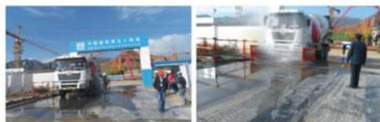
图七 大门出入口自动冲洗系统
