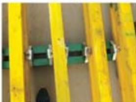
图2. 木梁连接扣连接钢背楞图
