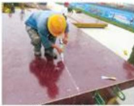
图4. 拼缝部位打密封胶图
