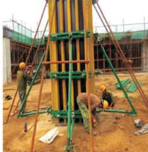
图10. 钢脚对拉支撑
