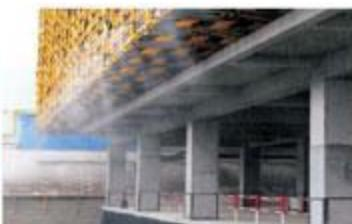
图二 外架底雾化喷淋系统
