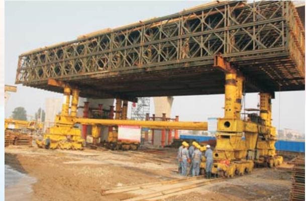
图3-3 自行式膺架梁现场施工图
