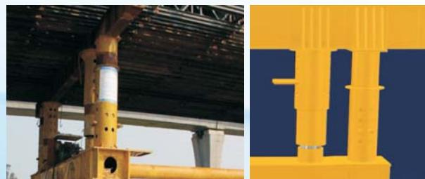
图2-4 立柱顶升系统实体图
