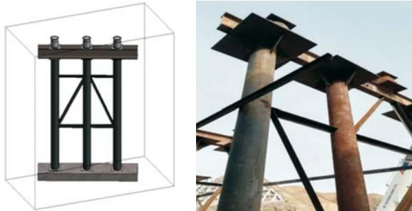
图5-14 钢管柱支撑体系
