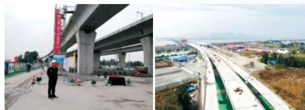
图4-1采用自行式整体膺架梁施工完成的现浇梁
