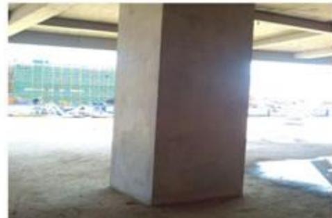
图12.清水混凝土型钢柱
