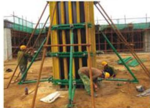
图11.钢脚对拉支撑
