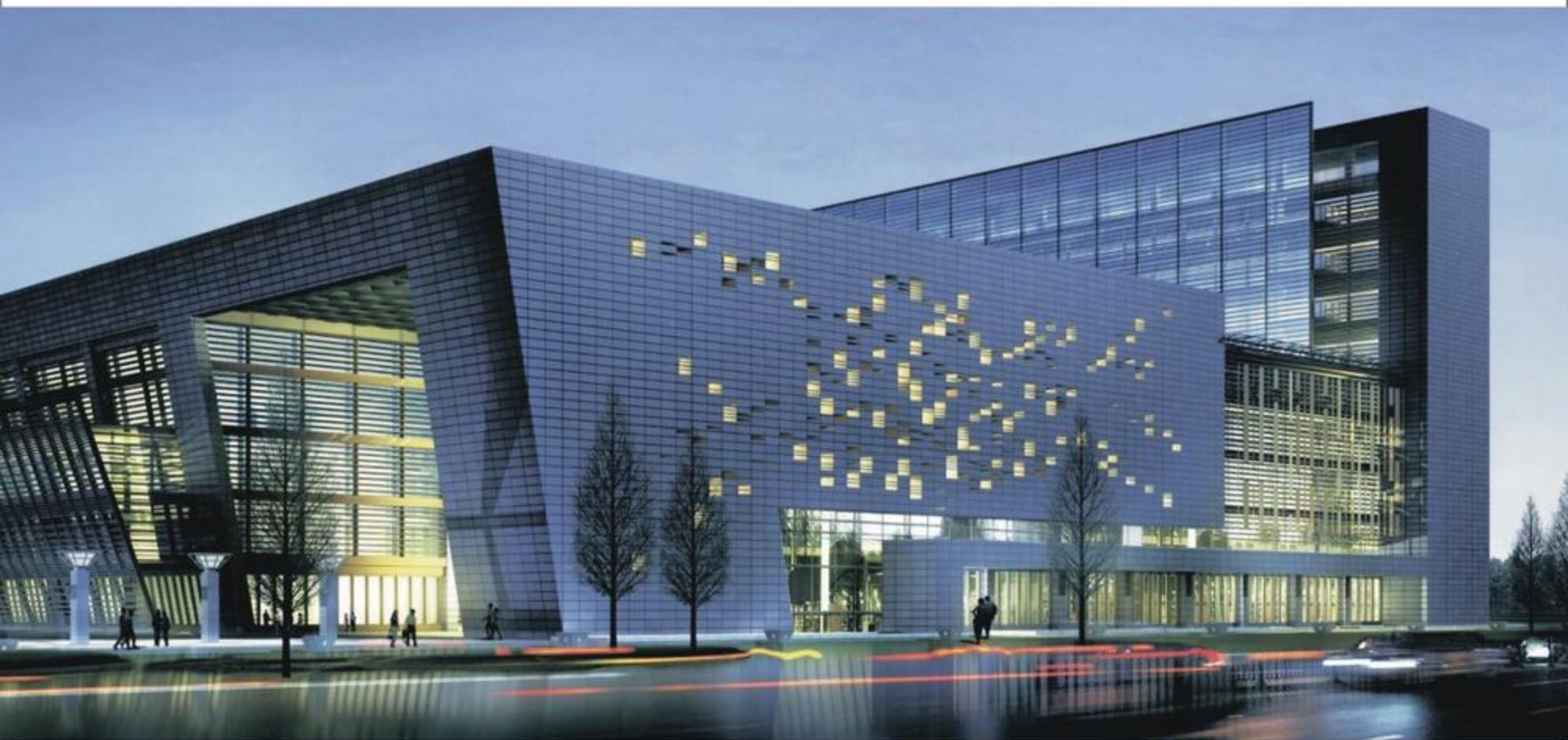
保温体系、呼吸式玻璃幕墙体系和节能门窗体系，节能率达到2.8%，每年节约能源约10万kWh。
