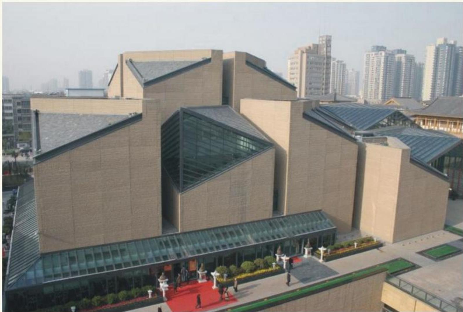
检测23份，全部合格。主体现浇梁板采用镜面复合板，10052m<sup>2</sup>混凝土表面平整，棱角方正、顺直，几何尺寸准确，外观质量达到了清水混凝土的效果，143组混凝土试块强度全部合格。钢结构焊缝超声监测、钢结构检测、化学锚栓检测、防火涂料检测等均合格。
