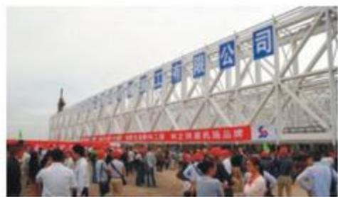
近日，位于陕西省西安西咸新区空港新城西部飞机维修基地首个项目，总投资3.8亿元的东航西安维修基地新机库155米跨钢结构整体提升圆满成功，为项目竣工奠定了坚实基础。
