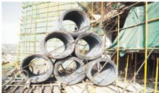
图-12 预加载试验
