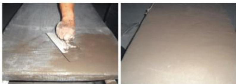
岩棉保温板包裹纤维网格布预抹面加工
