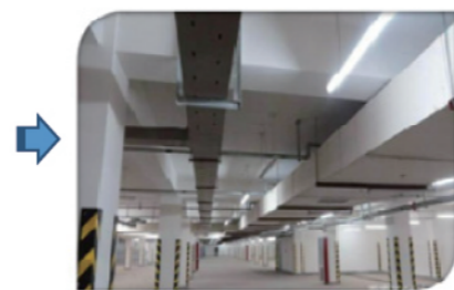
施工阶段启用永久通风设备
