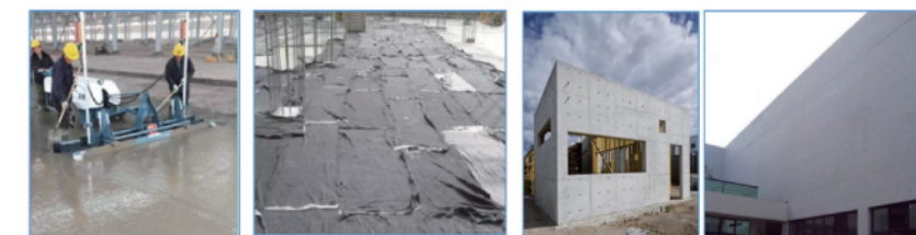
原浆一次找平 洒水养护 清水混凝土
