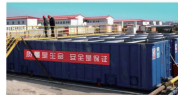
采用不透水、可周转泥浆池
