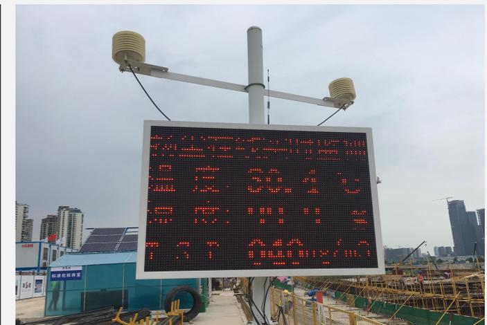
现场TSP设备与智慧工地平台对接，实时在线监测现场扬尘PM2.5、PM10及噪声，数据自动在平台中统计分析超预警值联动启动降尘喷淋降尘设施。
