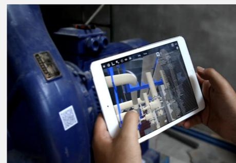
通过二维码信息, 对构件进行抽样检查, 并将检查结果通过移动端反馈回管理平台, 与模型进行挂接, 为后期运维提供数据参考。
